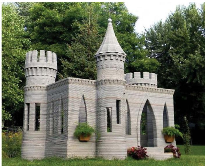
Рис. 18. Замок в Миннесоте, построенный с помощью портального принтера
