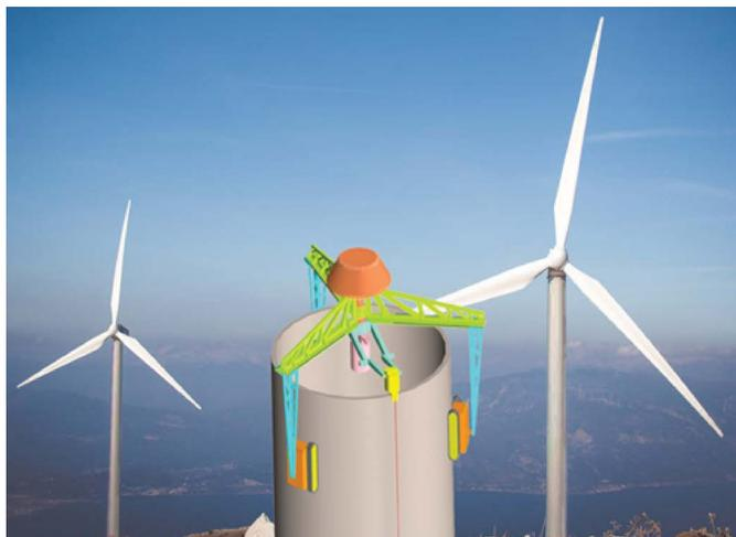
ня ограничена высотой крана, который можно смонтировать в данном месте (максимальная высота 85–100 м), и размерами секций башни, которые изготавливаются на заводе и должны быть доставлены на строительную площадку. Для доставки секций башни и крана требуется построить специальную широкую дорогу на ветроферму. Ее стоимость для фермы со 100 установками обойдется в \$30 млн.
