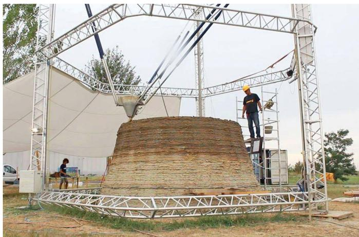
Рис. 8. Проект дома «бесконечная лента» и принтер ВАРМ, разработанный для реализации проекта
